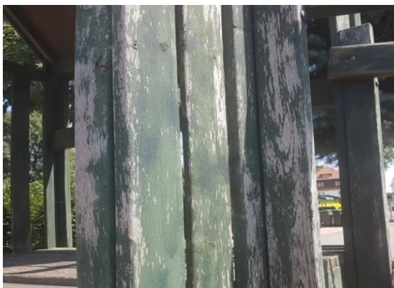
Aufarbeitung der Holzteile und neuer Farbanstrich
