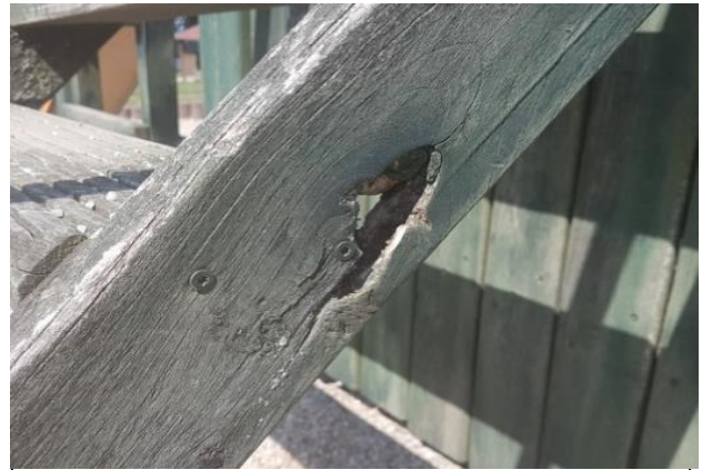
Austausch der Stützbalken
